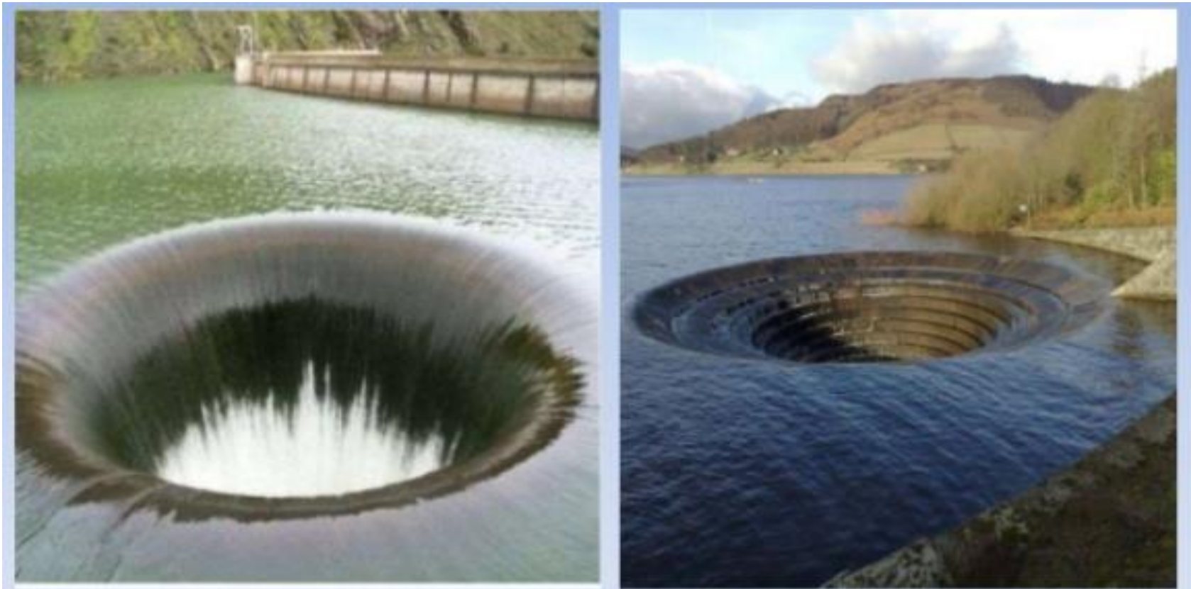
Shaft spillway
